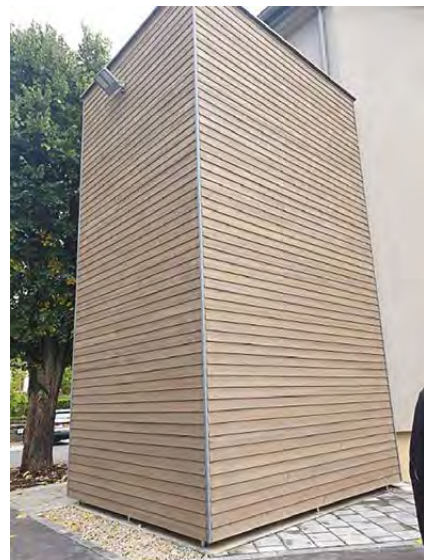
Abb. 34: Pelletaußenlagerung mit Umhausung. Bild: A.B.S. GmbH
