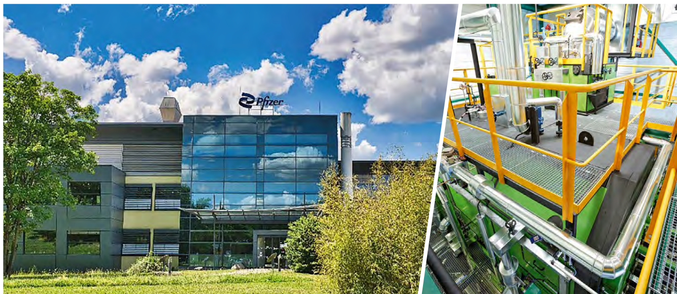
Abb. 3: Mit 3,8 MW Wärmeleistung war die Pelletanlage im Werk des Pharmaherstellers Pfizer am Standort Freiburg zum Zeitpunkt der Inbetriebnahme die größte ihrer Art. Bild: Pfizer Deutschland GmbH
